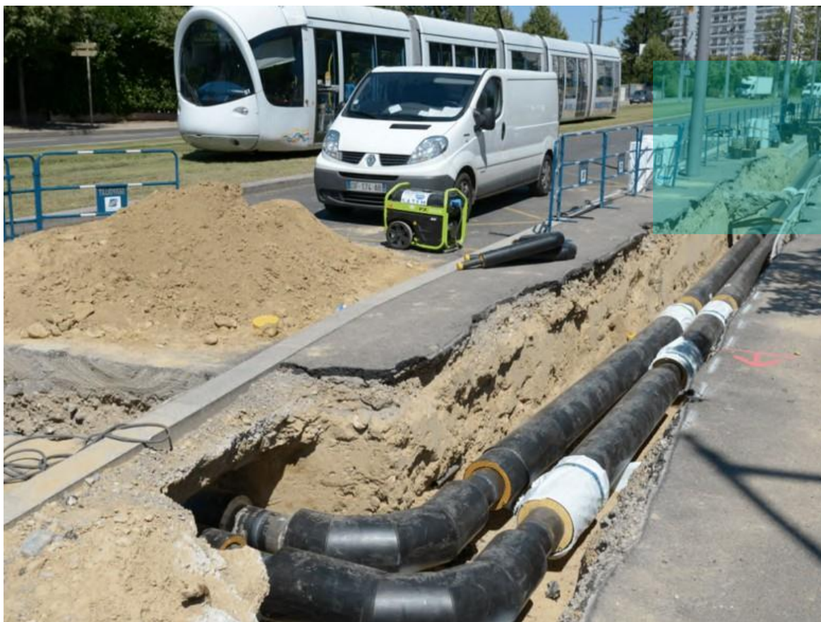
Extension réseau de chaleur (Source : Expression Vénissieux)
